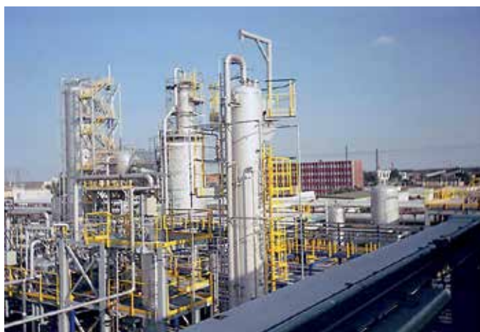
Travaux sur site : Décapage - Passivation
